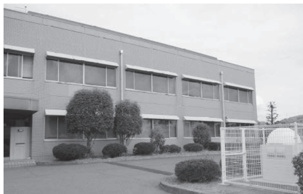
図-1 福井分析管理室局の様子(更新後)
