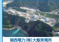
関西電力(株) 大飯発電所
