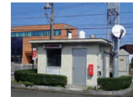
コンクリート局舎タイプ (A)
