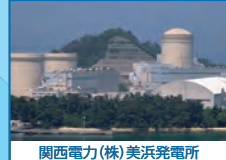
関西電力(株) 美浜発電所
