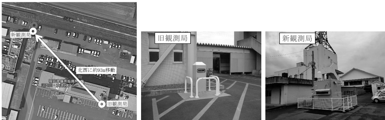
図－11 遠敷局 周辺環境変化 (福井県若狭合同庁舎南側駐車場→同庁舎北側駐車場)
