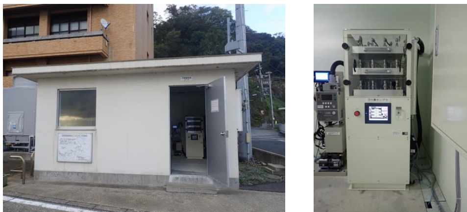
図-8 ヨウ素サンプラ設置状況（既設モニタリングポスト内設置）
