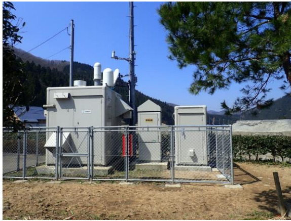
図-9 ヨウ素サンプラ設置状況（既設モニタリングポスト敷地内設置）
