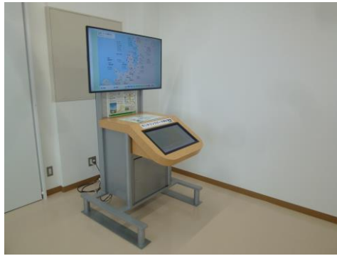
図-13 モニタリングデータ表示装置
