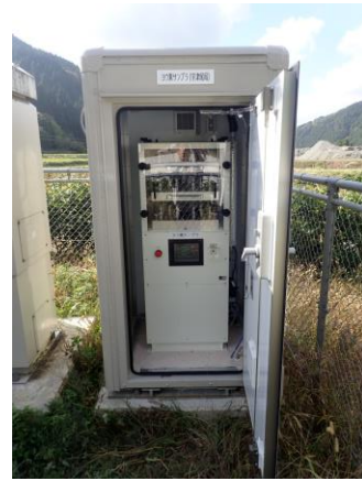
図-9 ヨウ素サンプラ設置状況（既設モニタリングポスト敷地内設置）
